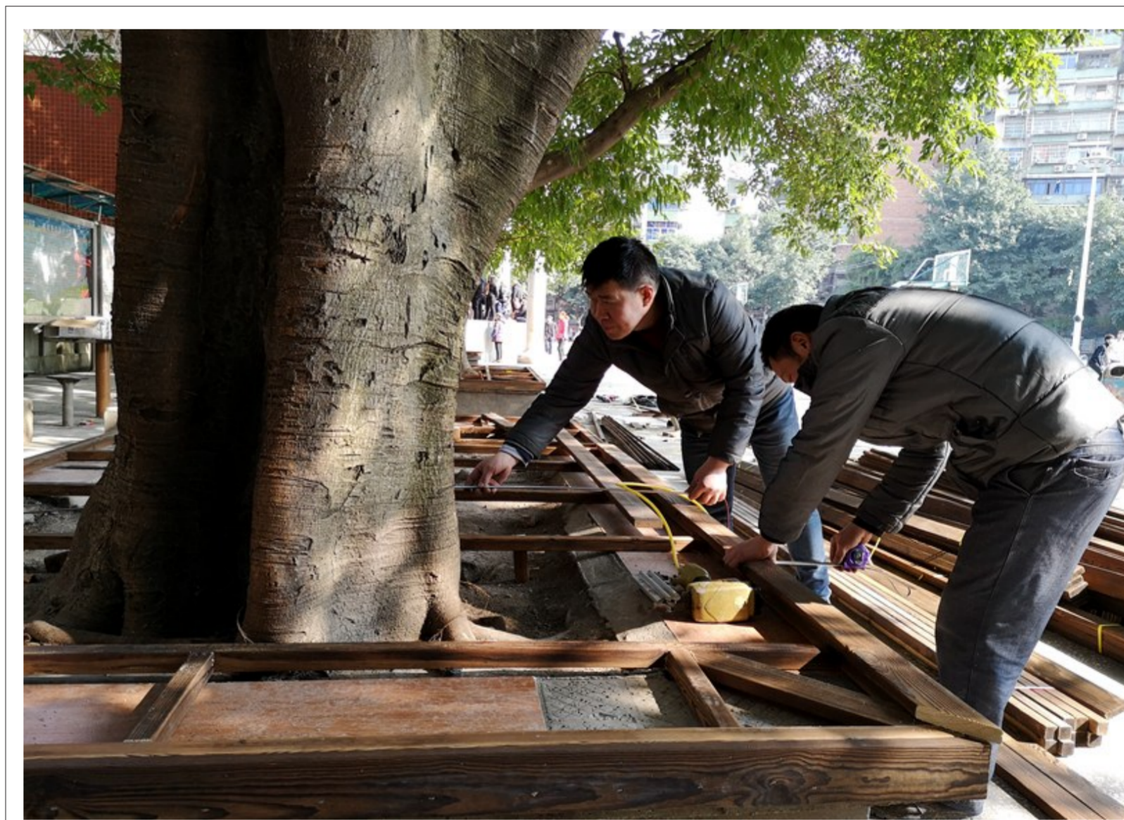
近日,记者在区工会体育场看到,几名工人正在维修体育场周边破损的休闲生椅,给市民营造一个整洁舒适的休闲环境。
