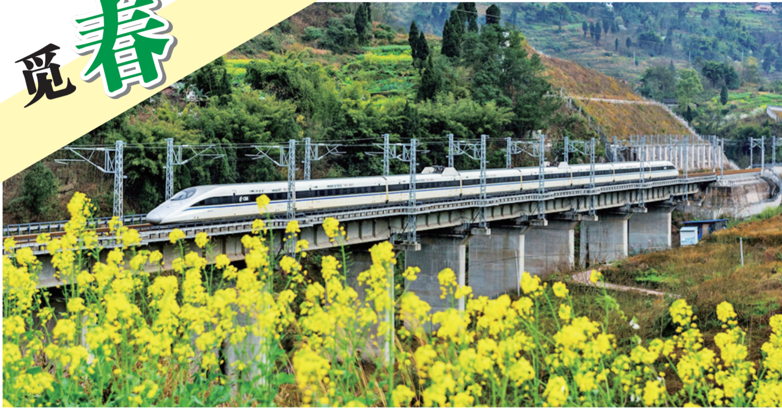
一列动车行驶在渝贵铁路三江街道水口大桥上，两旁油菜花盛开，呈现出春日美景。 通讯员 杨奇 摄
