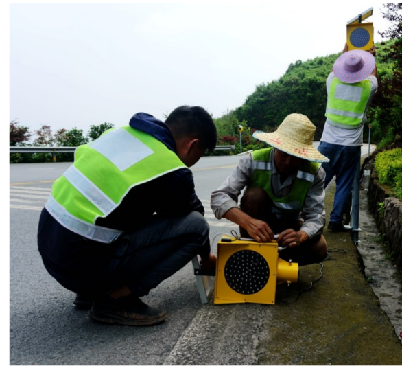
诱导雾灯目前已经安装完毕并投用
