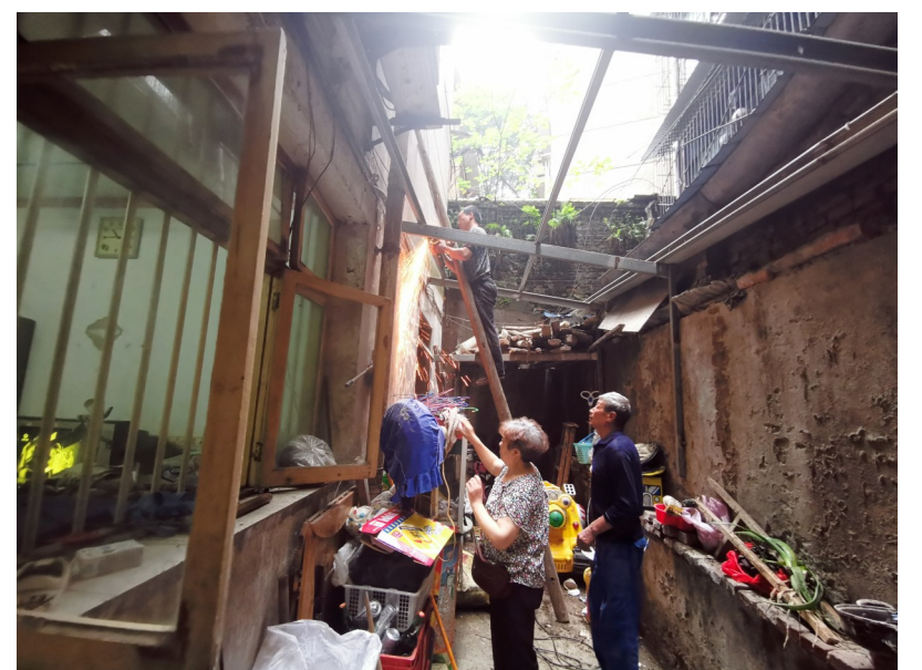
居民自行拆除“蓝屋顶” 记者 赵竹莹 摄
