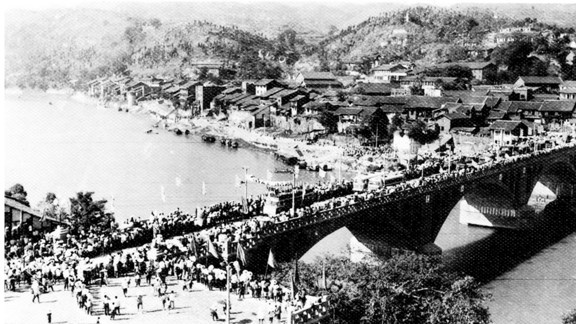
綦江大桥于1972年8月1日建成,举行通车典礼。綦江大桥横跨綦河,整体石拱砌成。它的建成不仅方便了两岸人民的往来,而且让綦江东部联通了川黔、川湘公路,至今都是重要的交通枢纽。
