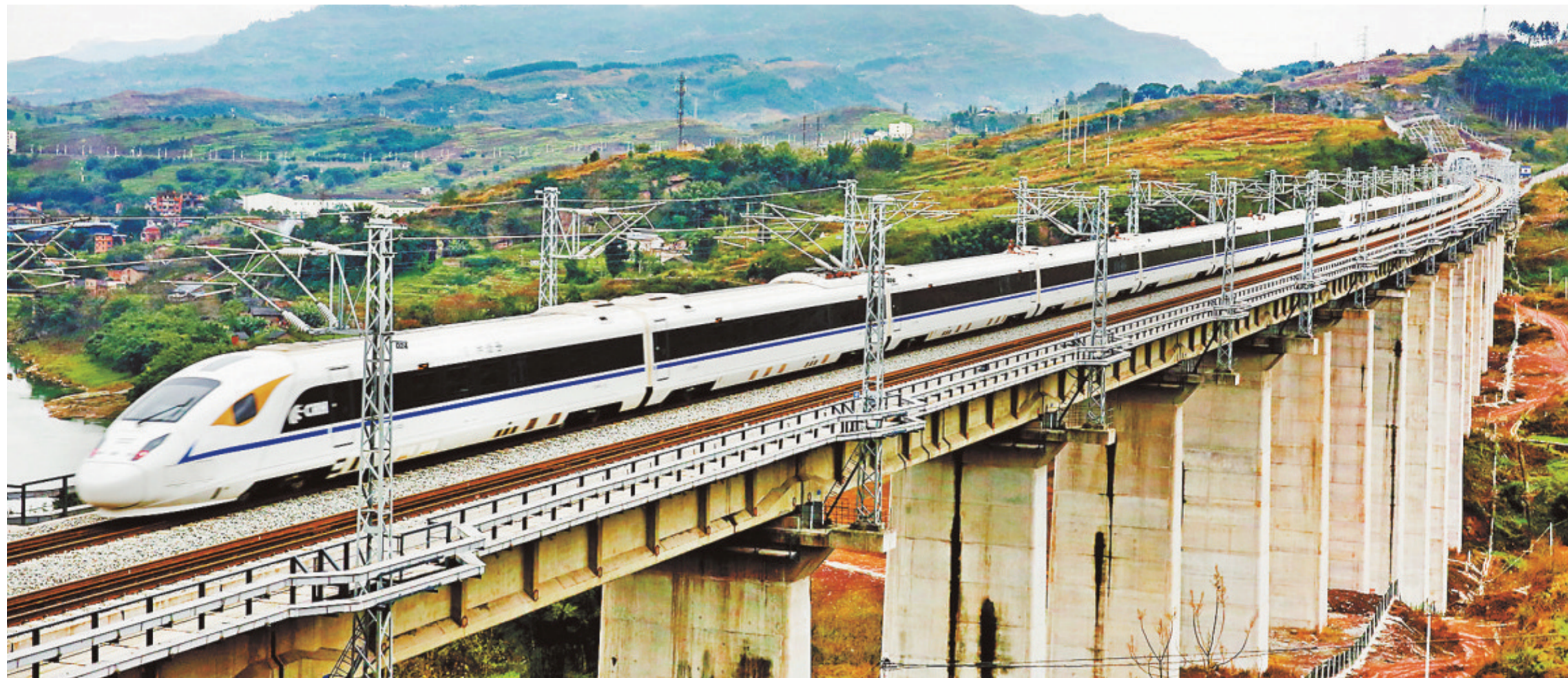
2018年1月25日,渝贵铁路首发列车驶过綦江王家湾大桥。当天,渝贵铁路正式投入运营,圆了綦江人的高铁梦。它的开通,不仅让綦江与主城距离更近,还为綦江构建南黔北交通枢纽创造了契机,构筑起渝黔合作新纽带。
