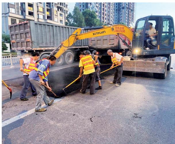
8月4—5日,区城市管理局开展专项修补行动,通过“热补”方式对城区“1516”路段、通惠污水厂路段、綦隆路路段、下北街路段等32个路段约400㎡坑洼破损路面进行集中修补。
