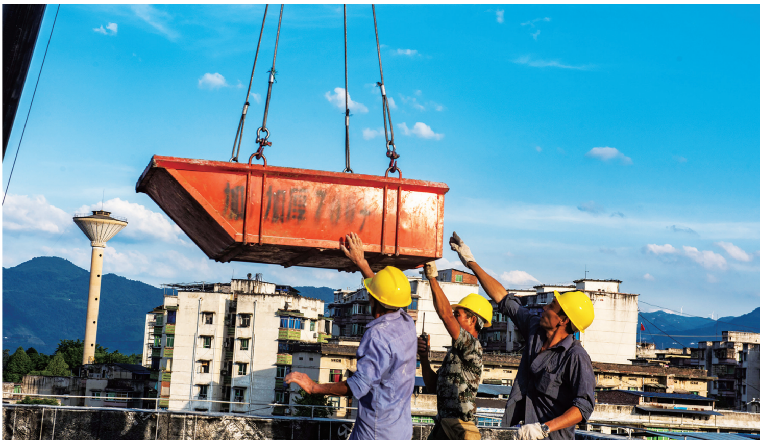
8月6日,打通镇打表推进“三供一业”改造项目,工人在高温下吊装建材,做好楼顶防水补漏工作。 通讯员 吴先勇 摄
