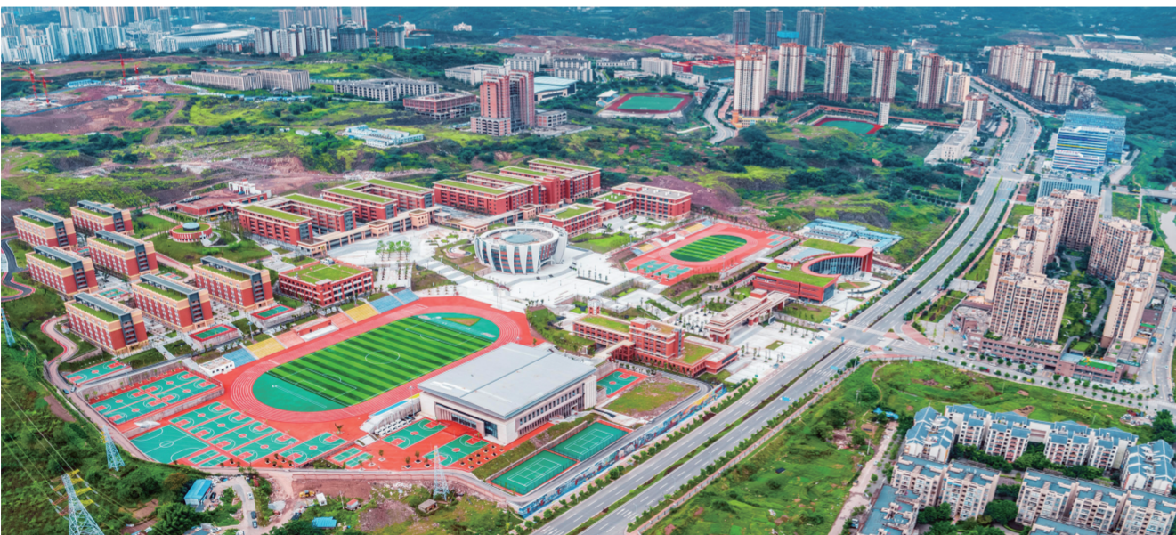
綦江中学迁建工程建设完毕。
