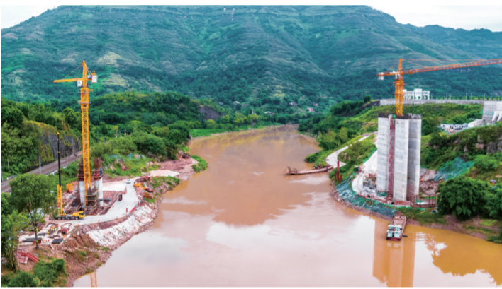
转关口大桥预计2021年7月完工。
