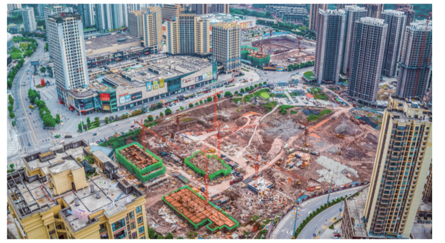
位于通惠核心商圈的千山天域项目正在紧张施工中。
