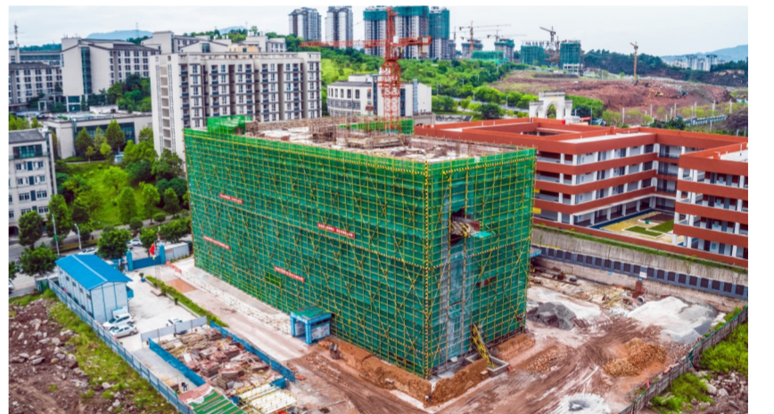
綦江区档案馆新馆建设项目已基本完成主体施工。
