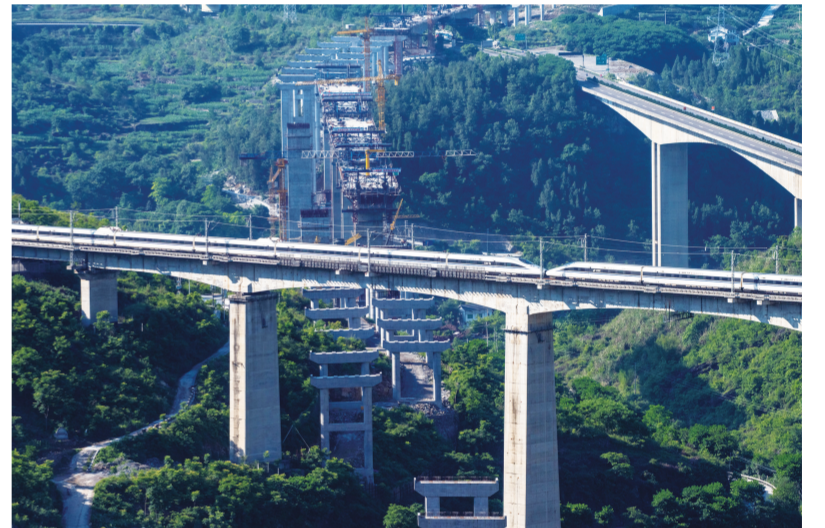
渝黔高铁穿过的在建的两合江特大桥。 通讯员 吴先勇 摄
