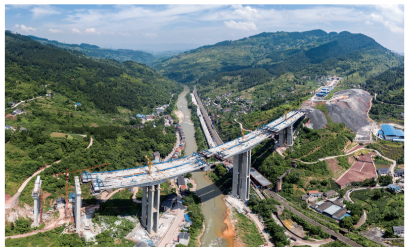
渝黔高速扩能项目——松坎河大桥。 通讯员 杨奇 摄
