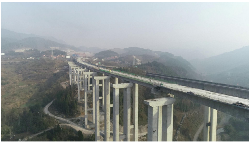
远眺正在建设中的渝黔高速扩能项目。
