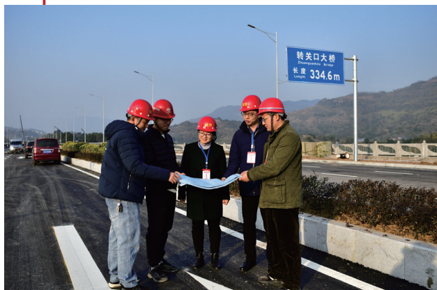
纪检监察干部在区级重点项目转关口大桥建设现场,监督相关职能部门和项目建设单位履责情况。
