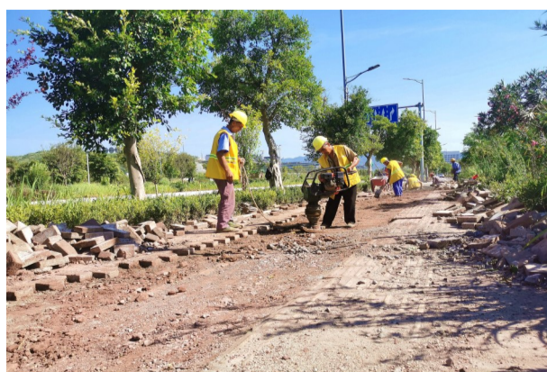
铺设供水管网解决吃水问题。记者 张静 摄
