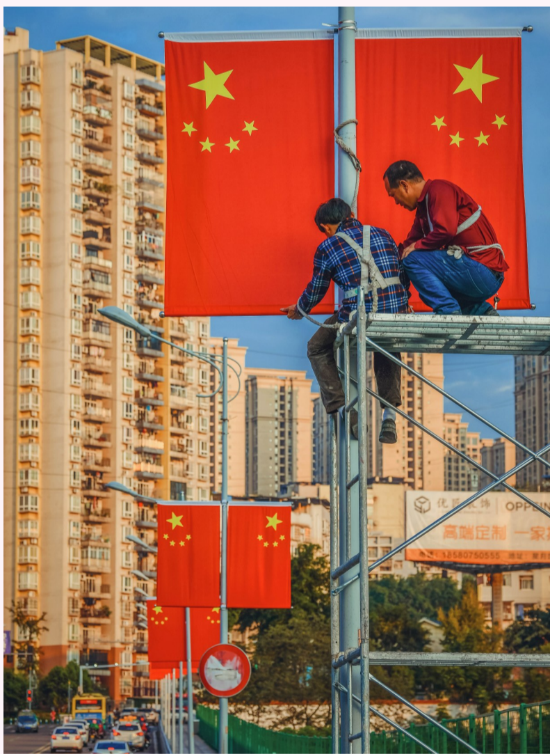
随着国庆节临近，綦江城区主次干道和重要节点被五星红旗和鲜花装饰一新，形成了一道靓丽的风景线。图为9月28日，城北大桥沿线，施工人员在紧锣密鼓地安装五星红旗。 记者 陈星宇 摄
