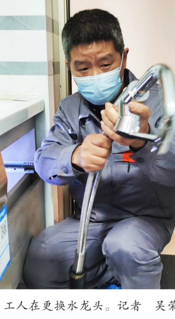
工人在更换水龙头。记者 吴荣凯 摄
