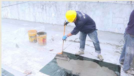
联惠社区对漏水房顶进行维修。记者 马卓 摄
