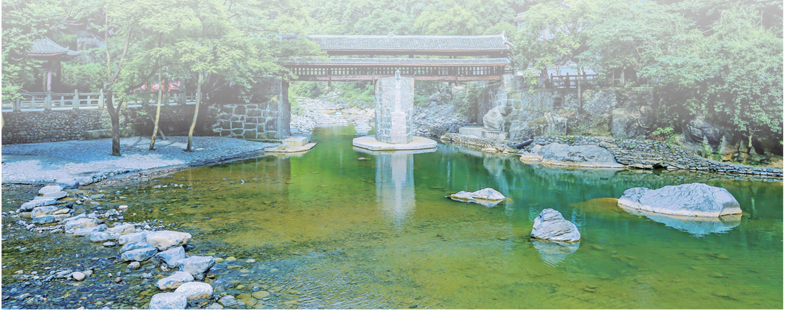
修缮完工后的石壕红军桥。
