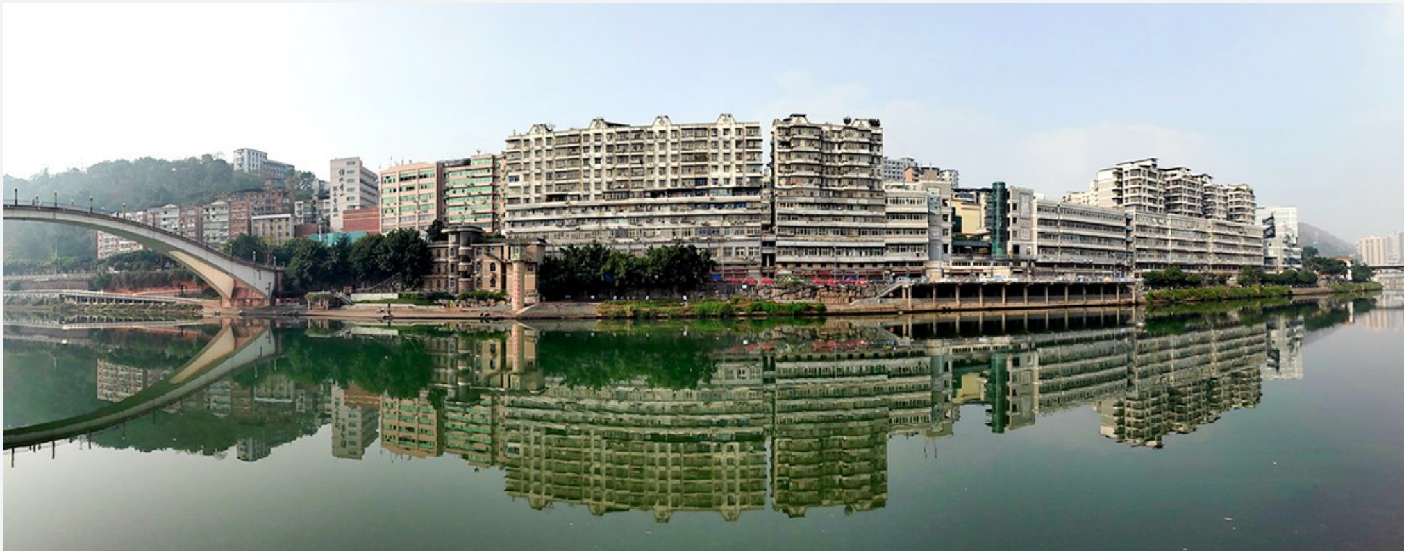
中山路的现代建筑倒映在綦河里,如身临江南水乡般美丽。记者 张学成 摄
