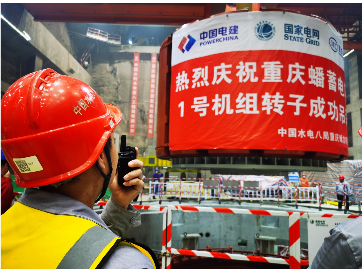
安装现场。记者 吴荣凯 摄
