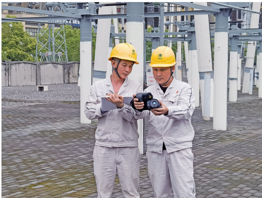
池永(右)正在检测变压器周围气温数据。特约通讯员 刘明 摄
