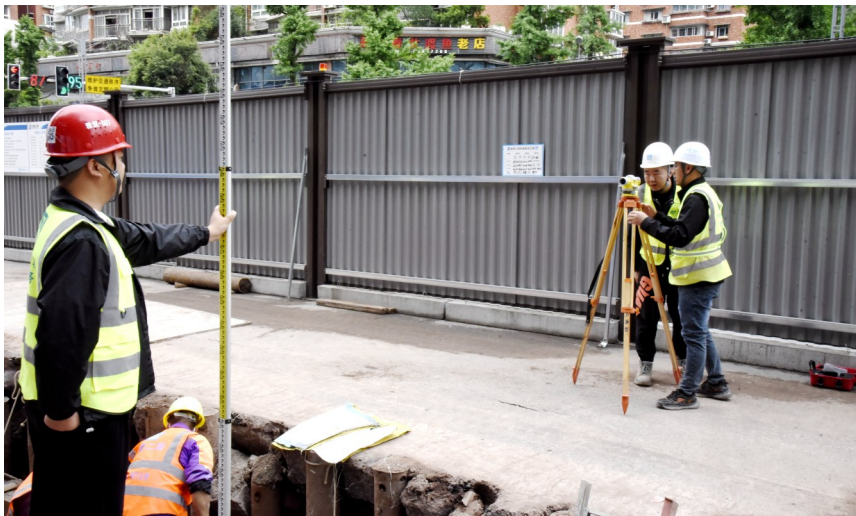
刘誉棋(左一)和同事一起测量钢管桩的间距。记者 刘琦 摄 战在一线。 “‘五一’期间,我们全员没有休假,主要的施工内容为沟槽的开挖和管道铺设。”中建二局綦江流域水环境综合治理项目生产经理王维表示,项目完成以后可以实现整个城区的雨污分流,从而减少对水环境的污染,同时实现居民生活污水的集中收集和处理。目前雨污管网改造已经完成11公里。
