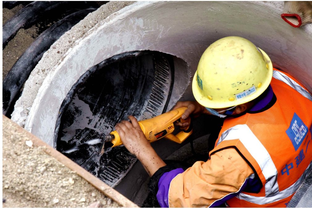
▲ 5月1日,蟠龙抽水蓄能电站施工现场,工人在对钢架进行稳固。 ▲ 5月1日,綦江城区雨污管网改造工程现场,工人在对井室管口进行打凿。
