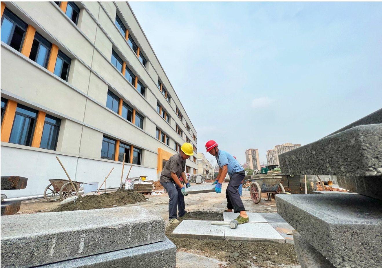
5月28日,在陵园小学通惠校区B区,工人们正在铺设道路。记者 成蓉 摄
