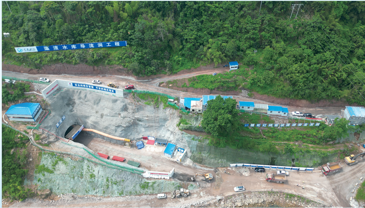
藻渡水库导流洞施工现场。记者 谢天骄 摄
