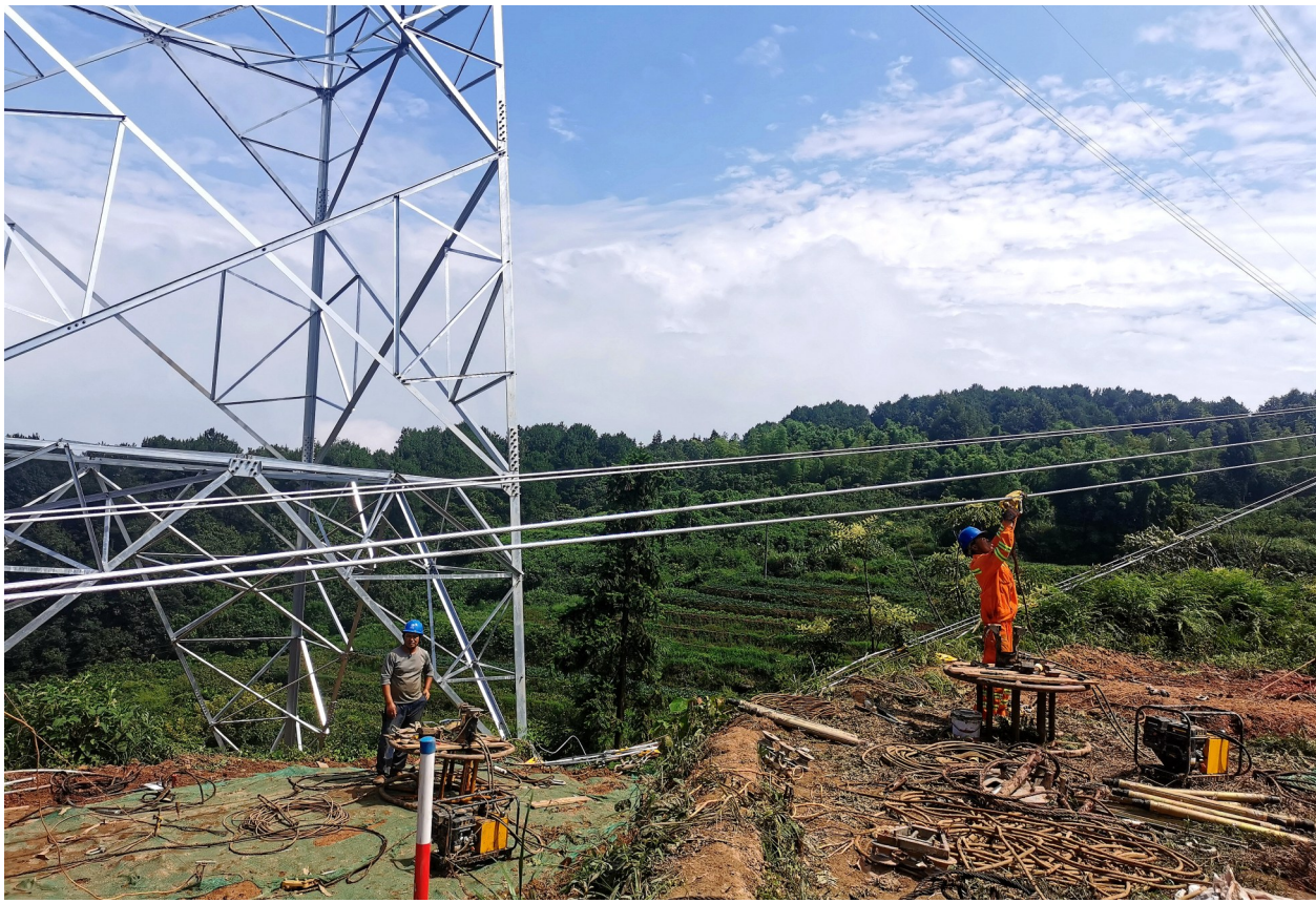
在永新镇八景500千伏送出工程39号铁塔施工现场,工人正在进行导线展放作业。记者 张静 摄
