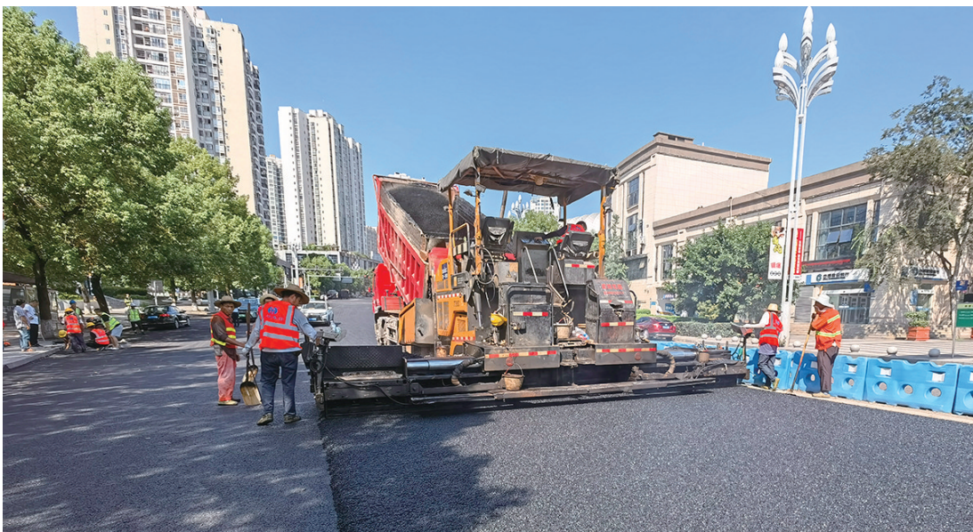
施工现场,沥青摊铺工在双重“烤验”下挥汗如雨。本组图/记者 杨圣龙 摄
