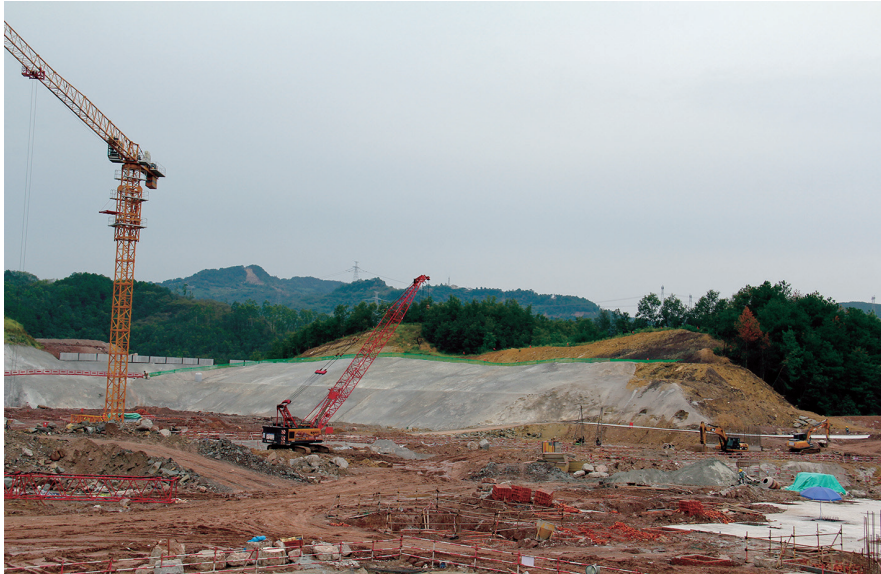
江苏省人民医院重庆医院建设项目施工现场。记者 杨圣龙 摄
