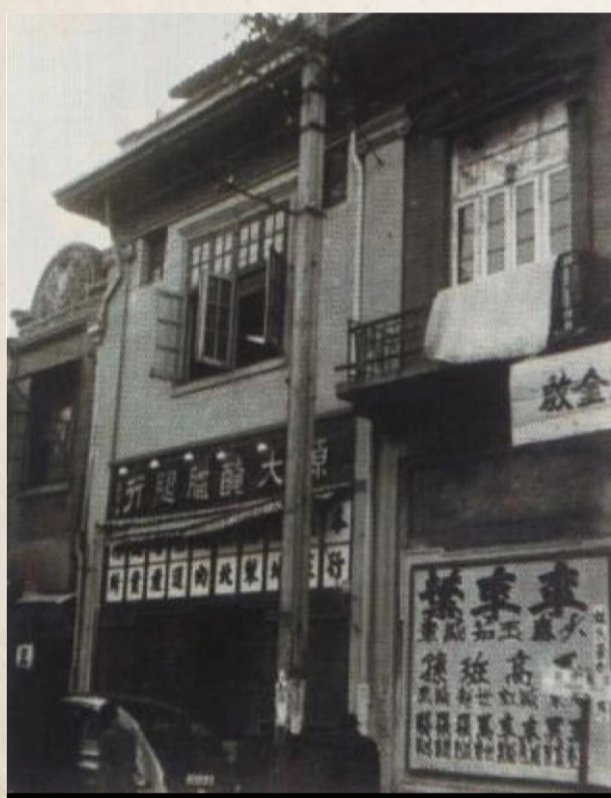
1928-1931年中共中央政治局在上海的机关旧址。
