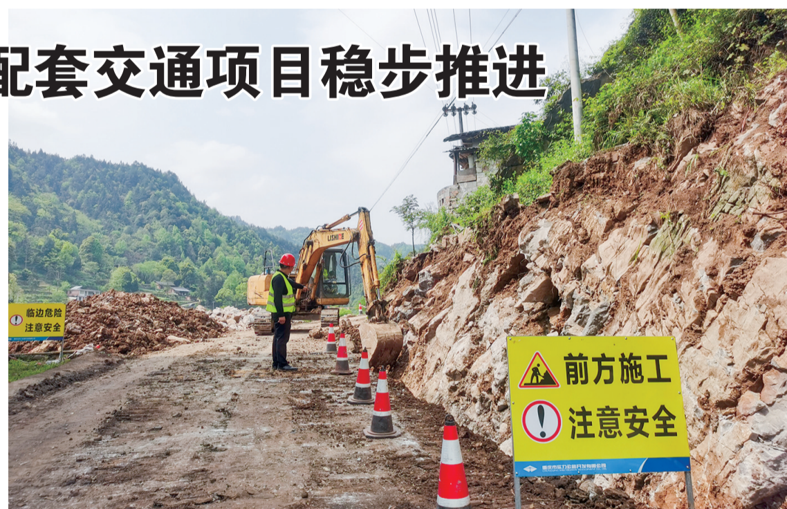
施工现场。通讯员 雷飞 摄
