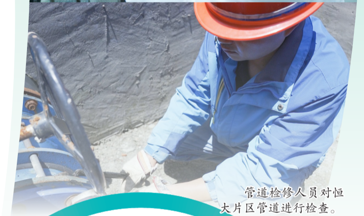
文龙水厂水质检测站工作人员正在进行水质检测。
