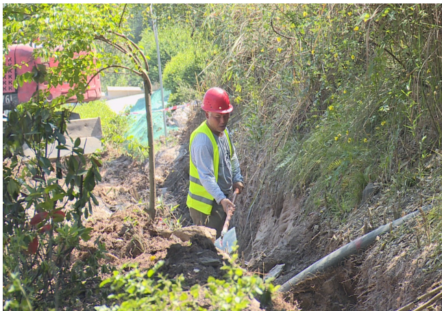
高新区施工现场,工人正忙着开挖管沟。记者 谢鹏飞 摄
