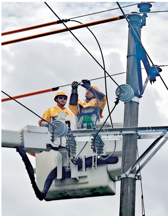
国网重庆綦江供电公司工作人员正在搭电作业。记者 魏源森 摄
