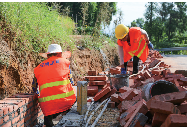
乐升坪村,工人整治边沟。记者 杨静 摄
