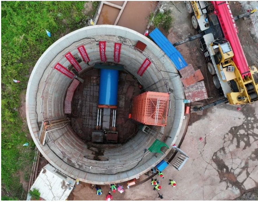
8月22日,綦江,重庆市藻渡水库输水工程盐井坝倒虹吸顶管段已实现贯通。新重庆—重庆日报记者 罗斌 摄
