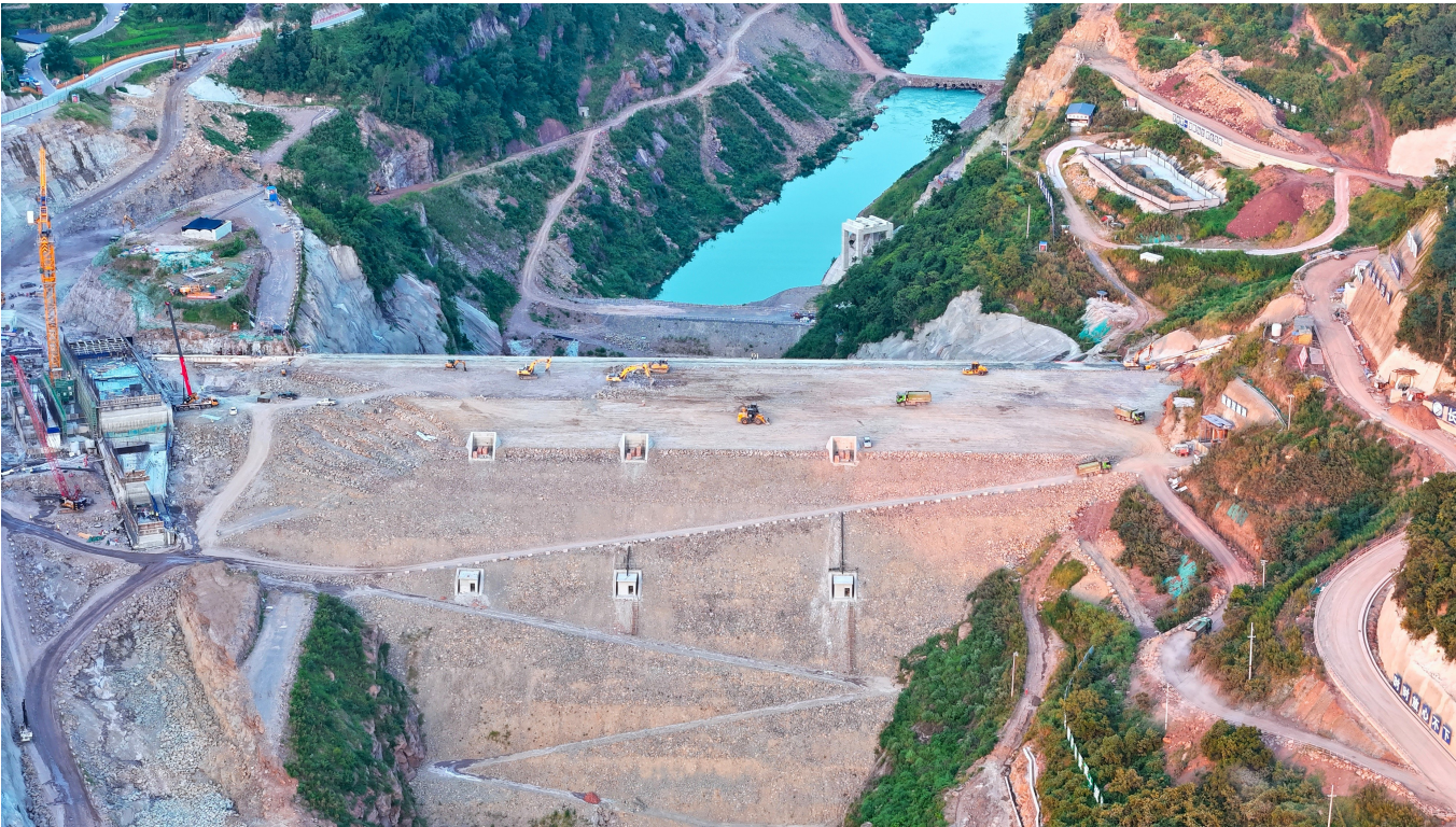
藻渡水库工程正在进行大坝填筑。特约通讯员 湛江涛 摄
