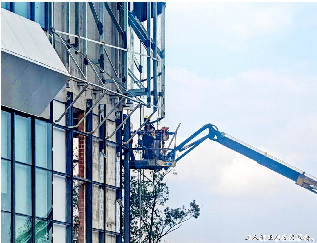
工人们正在安装幕墙。
