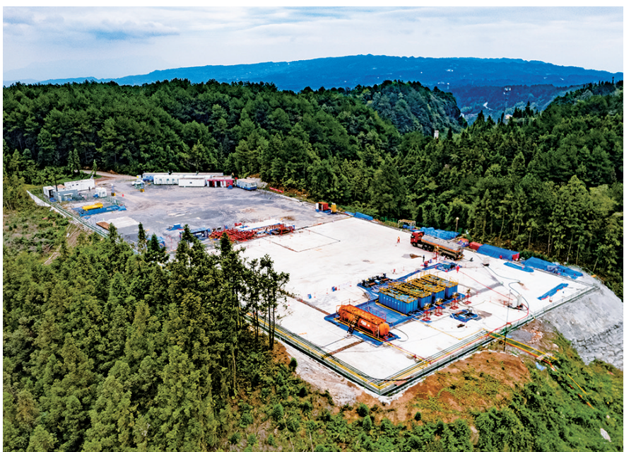
位于綦江区郭扶镇的綦陆页1井。记者 周禹 摄
