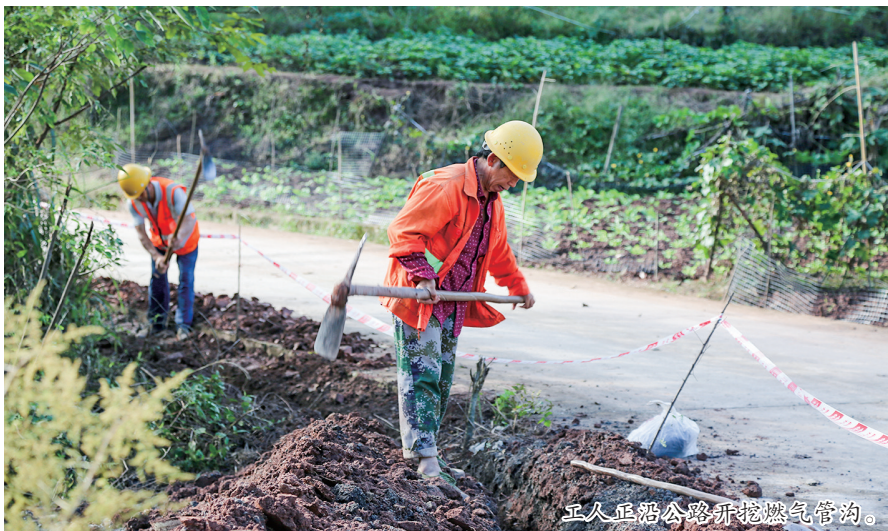
正久正路公路开挖燃气管沟。
