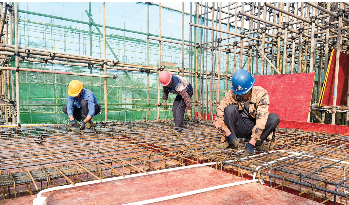
工人们正在加紧施工。记者 杨圣龙 摄
