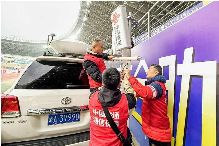
重庆联通綦江分公司工作人员正在架设移动基站。记者 成蓉 摄
