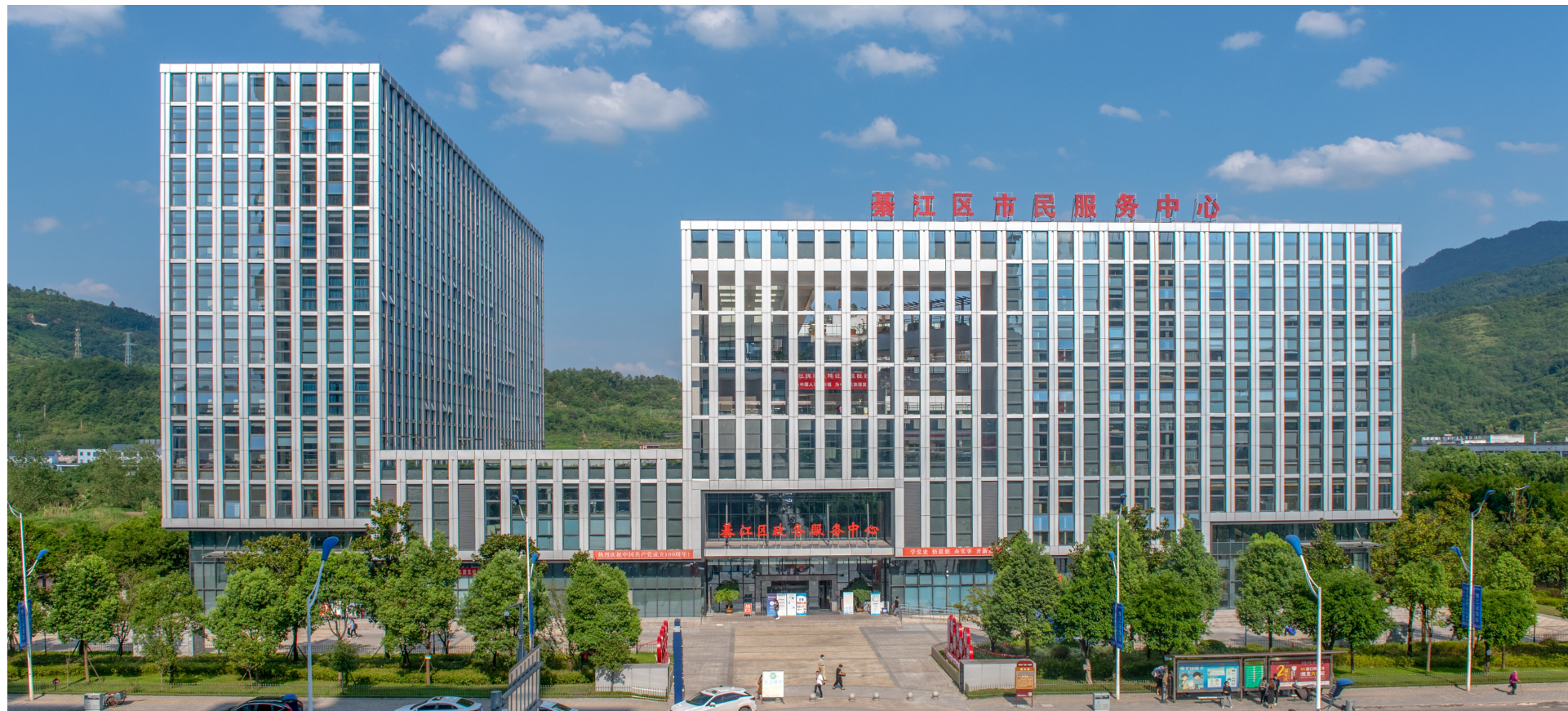
区政务服务中心大楼。通讯员 段贵华 摄
