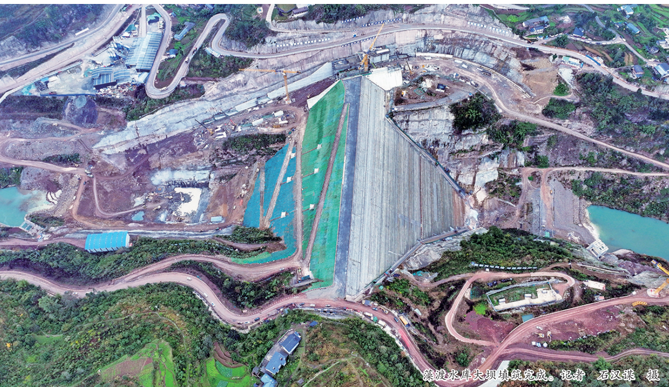
藻渡水库大坝填筑完成。记者 石汉谋 摄
