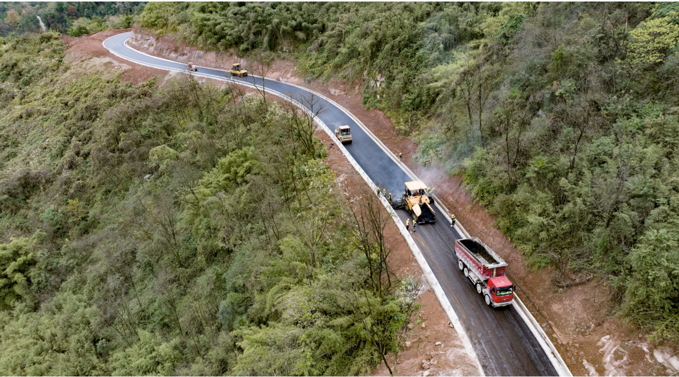
老瀛山环线公路施工现场。记者 周禹 摄
