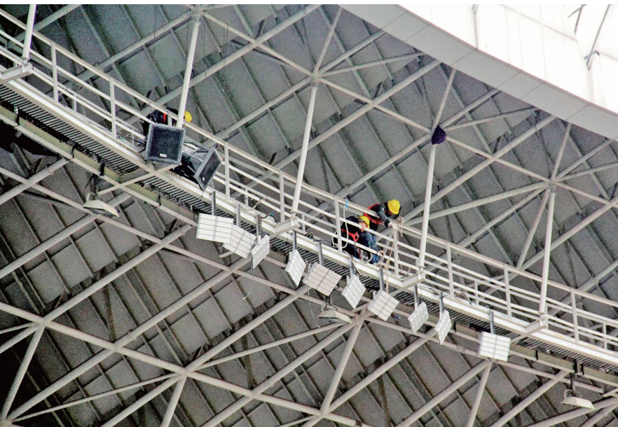
綦江体育中心,工人正在更换灯具。记者 魏源森 摄
