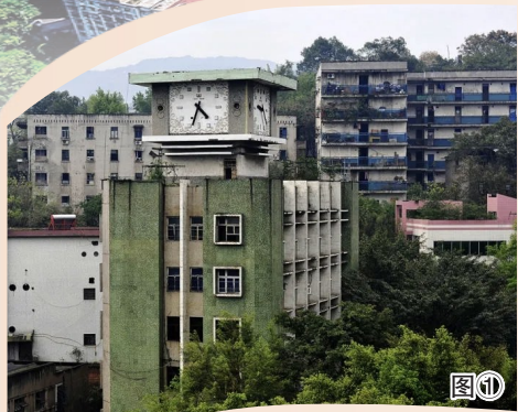
图①:原重庆钢铁公司第四钢铁厂生活区内的建筑。(受访者供图)
