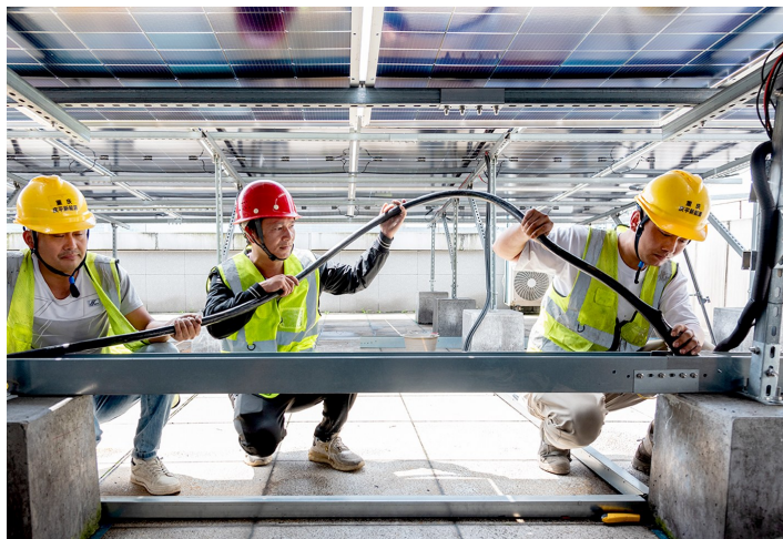
区妇幼保健院,工人把电缆线装进桥架。记者 杨晨 摄
