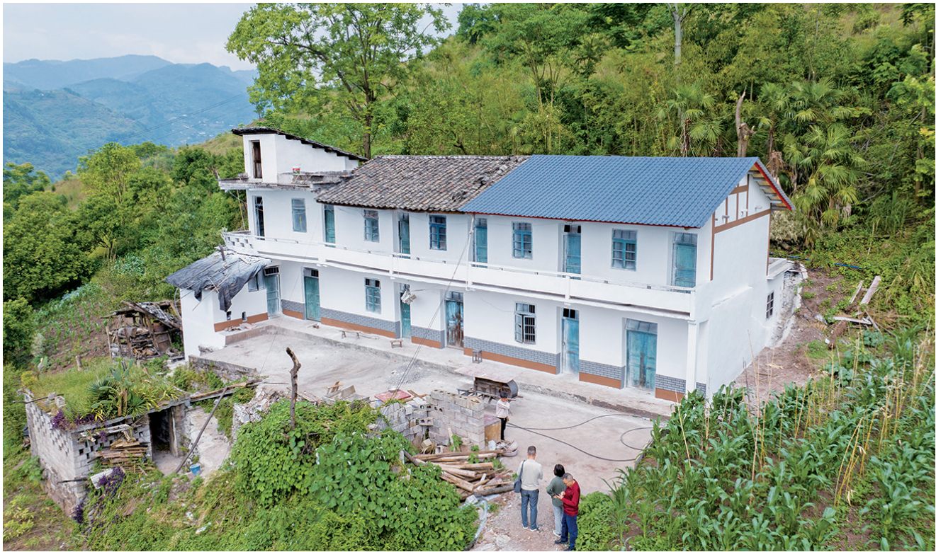
安稳镇采煤陷区,C级农村自建房排危改造后,旧貌换新颜。记者 周禹 摄
