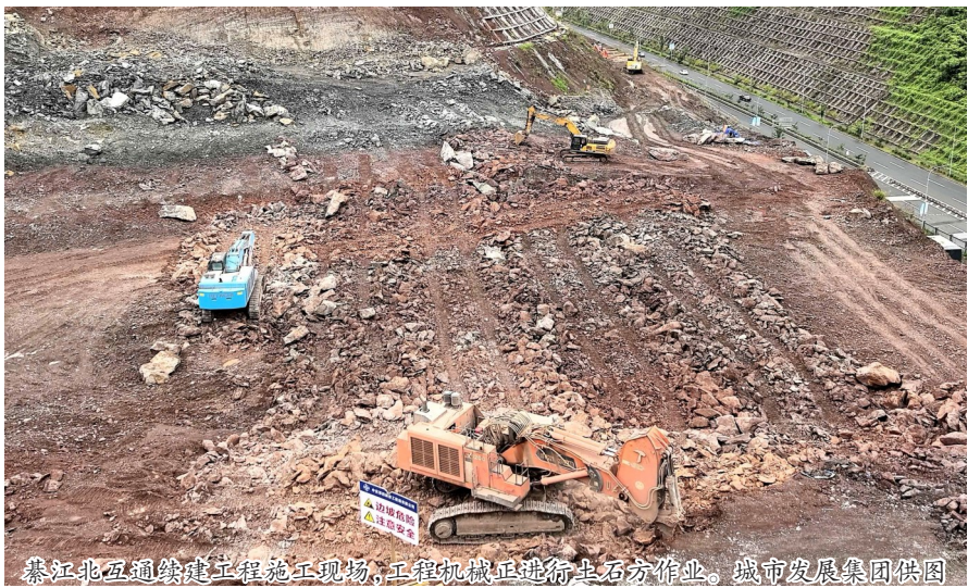
綦江北互通续建工程施工现场,工程机械正在进行土石方作业。城市发展集团供图
