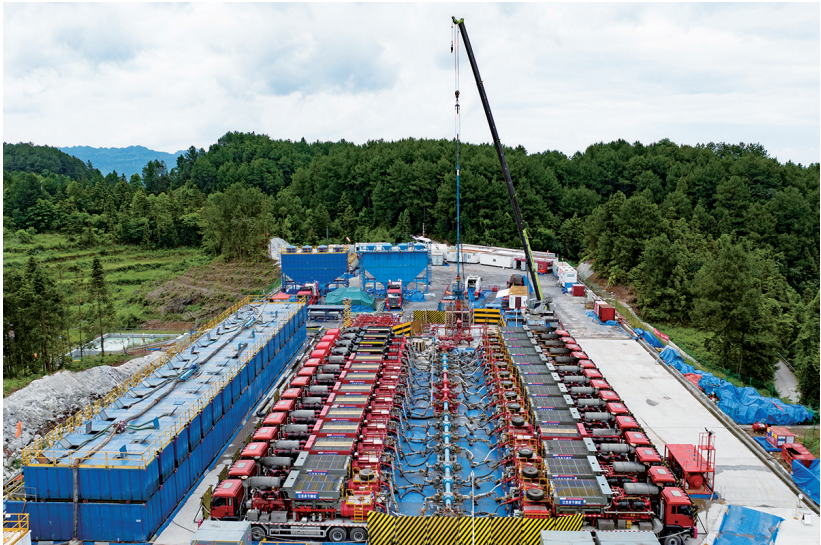
中国石化勘探分公司部署在重庆市綦江区的风险探井——基陆页1井。
