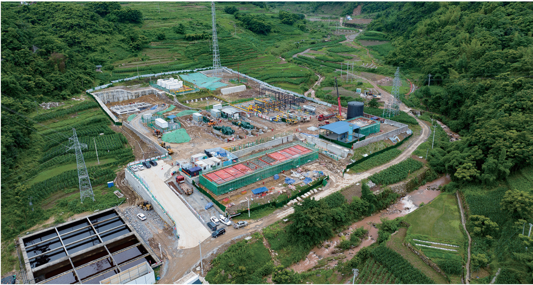
扩能建设中的中国石化西南油气分公司采气四厂丁山总站。该项目今年7月建成后,日处理页岩气可达200万立方米。
