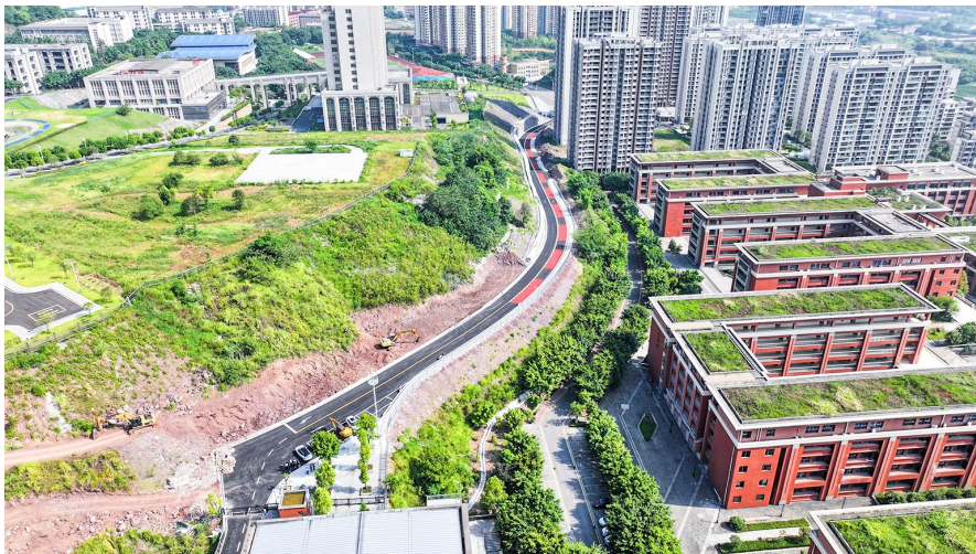
已经建成的登科府西侧道路。记者 石汉谋 摄
