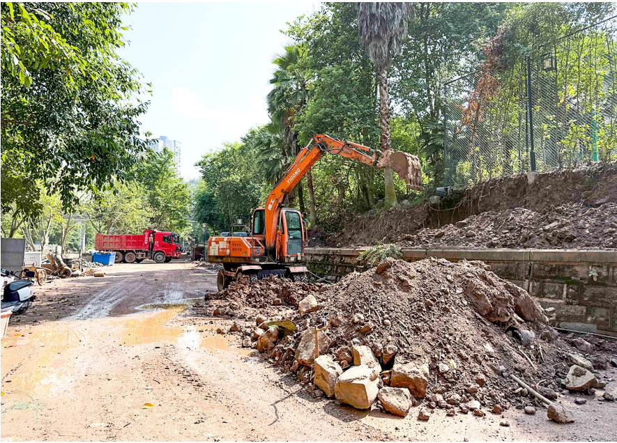
挖掘机对改造完成的截污干管沟槽开展回填作业。记者 成蓉 摄
