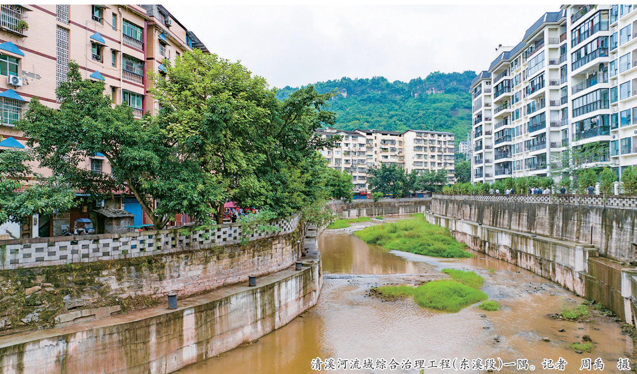
清溪河流域综合治理工程(东溪段)一隅。记者 周禹 摄
