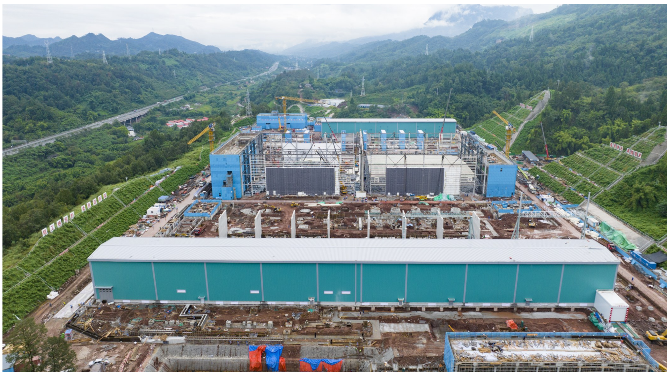
西南首座柔性直流背靠背换流站建设现场如火如荼。记者 周禹 摄
